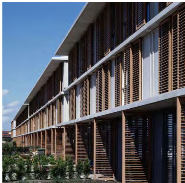
VLOEREN LATEN SPREKEN
